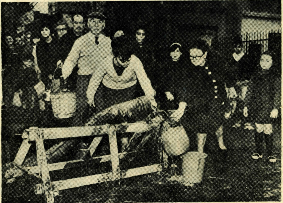
Frente a la manga del motobombeador instalado por Obras Sanitarias de la Nación en la esquina de Membrillar y avenida del Trabajo forman fila los vecinos con toda clase de recipientes para proveerse de agua
