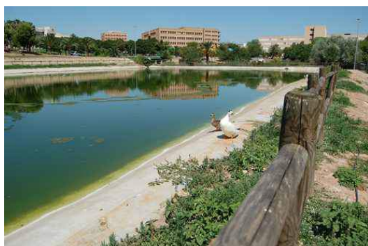
Figura 4. Depuradora simbiótica del Campus de Espinardo
